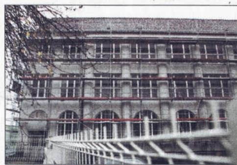
Oldtimer auf dem Sprung: Bis Juni soll das Haus mit den markanten Säulen und Bogenfenstern in Glanz erstrahlen, innen hochmodern hergerichtet sein.
