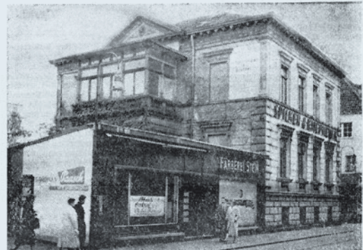
Das Grundstück Bahnhofstraße 17, seit 1. Mai im Besitz der Karstadt-AG., wird während der Um- und Aufbaubarbeiten an der Ecke Bahnhofstraße/Stresemannstraße als Ausweichplatz für die Kepa dienen, die nach dem Abbruch der alten Gebäude behelfsmäßige Verkaufsräume dort errichten will
